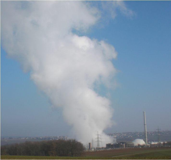
Das AKW noch mit dem bereits 2011 abgeschalteten Block 1.
